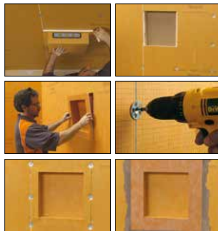
Instalação em KERDI-BOARD
