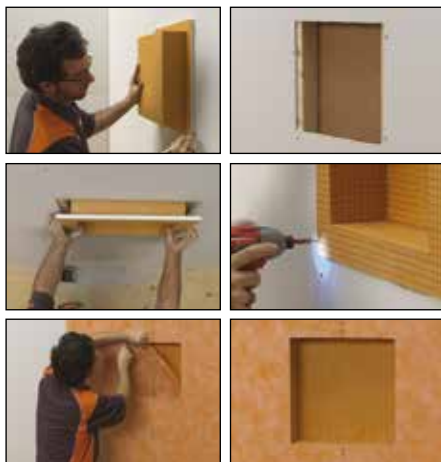
Instalação em gesso cartonado
